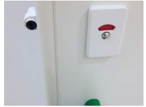
Abb. 3: WC-Tür mit integriertem Klemmschutz mit Weichlippenprofil
