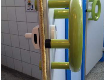
Abb. 2: WC-Tür mit integriertem Klemmschutz mit Bürste
