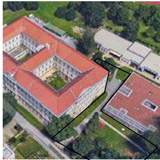
Abb. 33: Luftbild C2 mit Grundstücksgrenze
