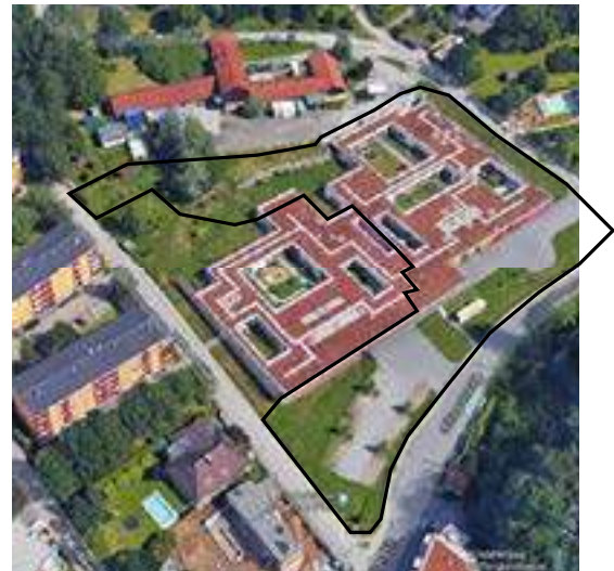
Abb.39: Luftbild C3-01 mit Grundstücksgrenze
