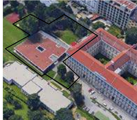
Abb. 27: Luftbild C1 mit Grundstücksgrenze
