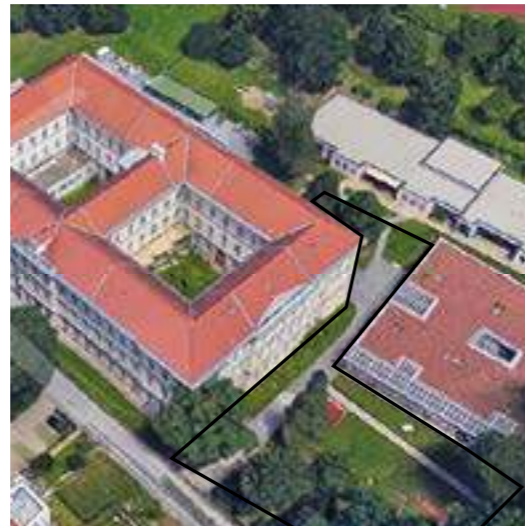
Abb. 33: Luftbild C2 mit Grundstücksgrenze
